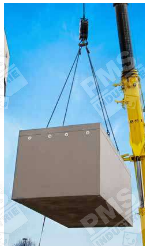
Levage avec chaînes uniquement.
