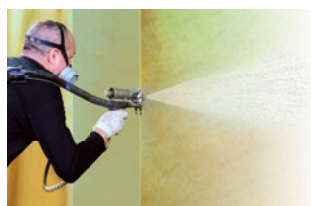
Projection du polyuréthane
