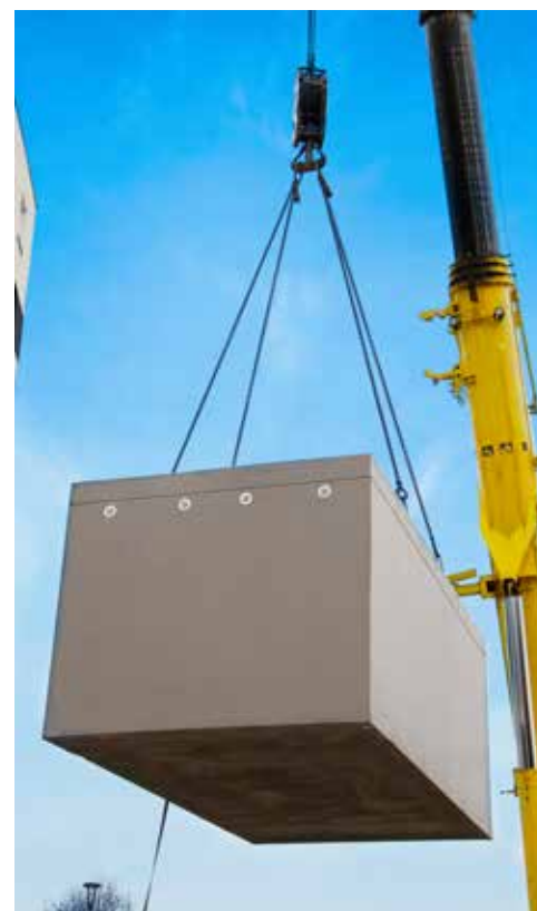
Levage avec chaînes uniquement.
