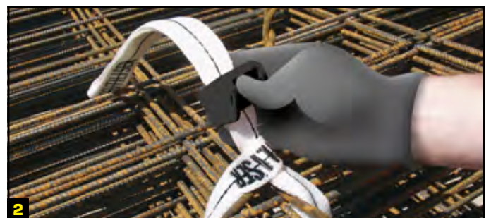
2 Faire coulisser l'ensemble au maximum, le plus près possible du paquet de treillis. Verrouiller le système Li-1 en appuyant sur la partie supérieure de la pièce. Enfoncer le poussoir jusqu'au "CLIC".
